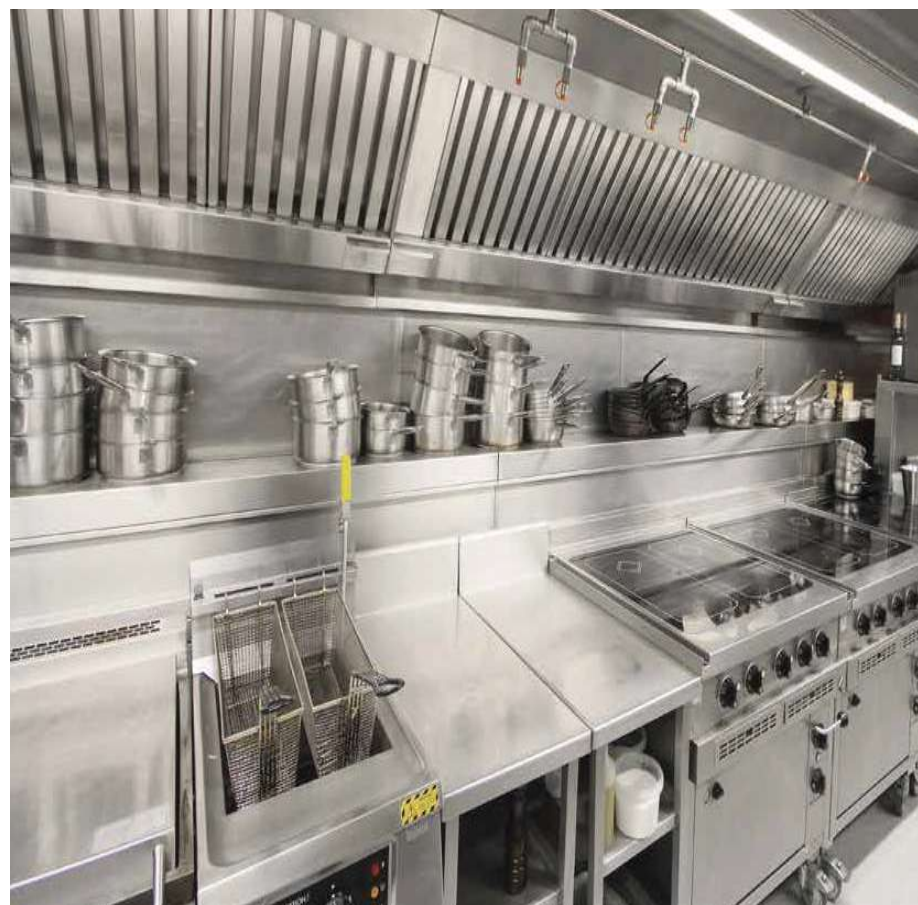
Hệ thống chữa cháy tự động
